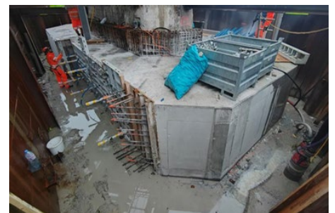
Betonierung des Mittelpfeilers bei der oberen Aarebrücke
