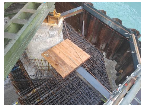
Bei der oberen Aarebrücke wird der Mittelpfeiler gebohrt.
