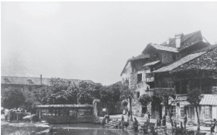
Abb. 95 – Unter den Häusern, mit Torisau- sgang ((Gewölbe) zu einer Aaretreppe führend, Foto um 1890
